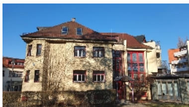
Ostansicht Bauteil E vor Abbruch
